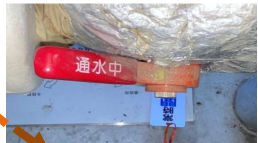
給水弁の拡大図
