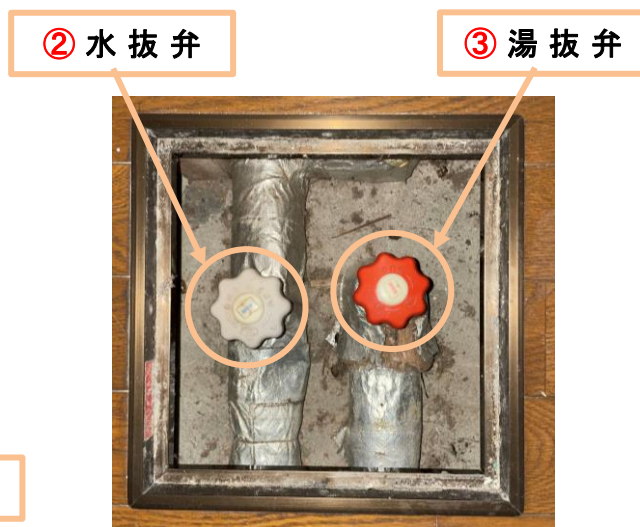
室内の床ハッチ
