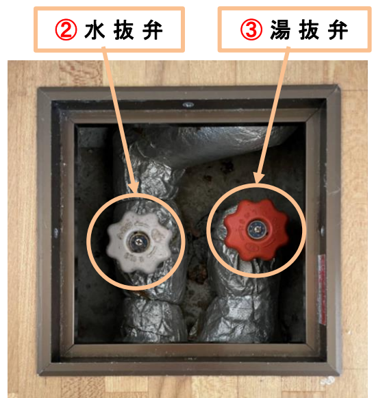
室内の床ハッチ
