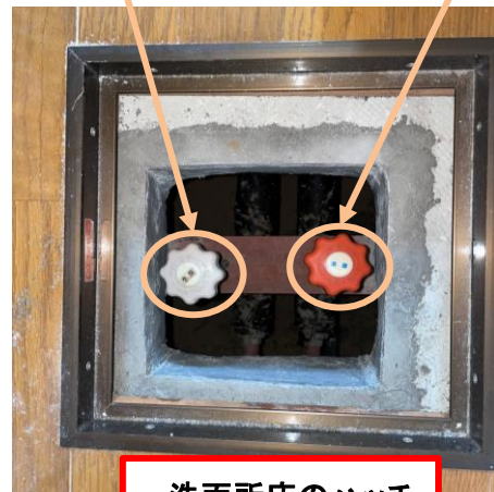
洗面所床のハッチ
