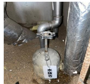
パイプシャフトの水抜き弁拡大図
