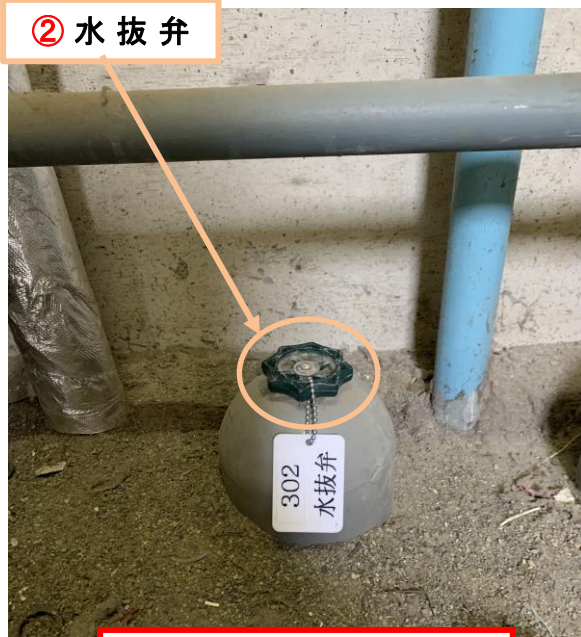
パイプシャフトの床
