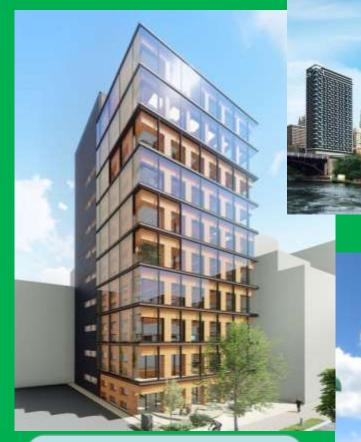
大林組研修施設(横浜) 純木造免震構造 (耐火建築物)11階
