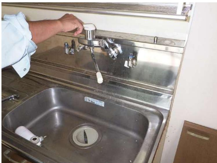
1・水抜き時に開けた水栓を閉めて下さい。
