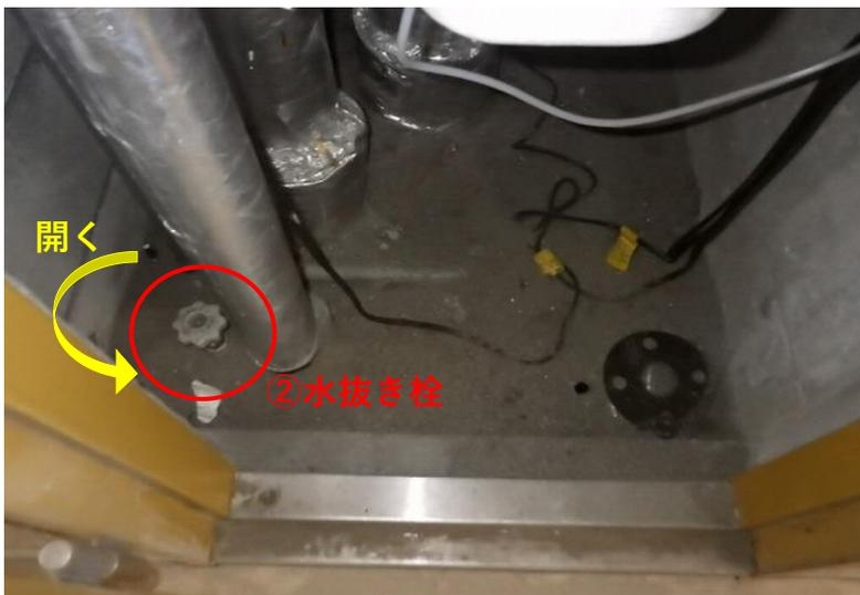
2・②の水抜き栓を開けて下さい。
