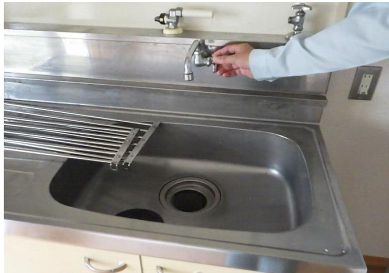
1・水抜き時に開けた水栓を閉めて下さい
