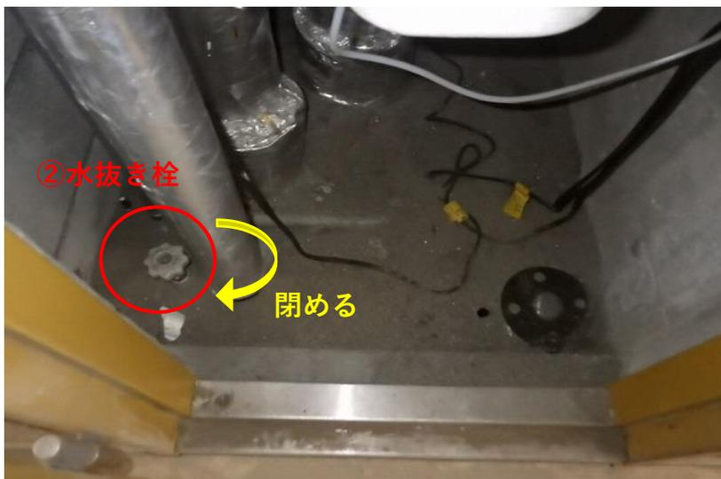
2・②の水抜き栓を閉めて下さい。
